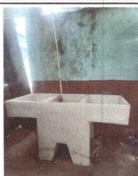
Foto 14: Sustitución de pila de cemento de dos lavadero
