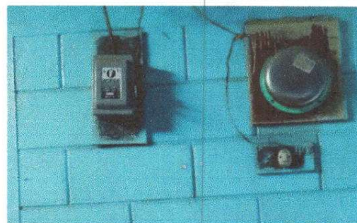
Foto 12: Sustitución de flipon e interruptor
