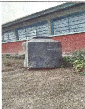
Foto 13: Sustitución de deposito de agua 1100 lt
