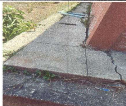
Foto 10: Reparación de banqueta de concreto
