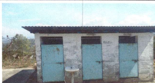
Foto 4: Sustrucción de puertas en servicios sanitarios
