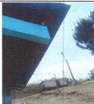
Foto 6: Sustrucción de canal de pvc
